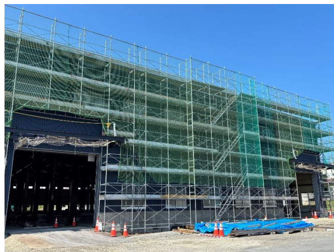
建設中の工場外観
