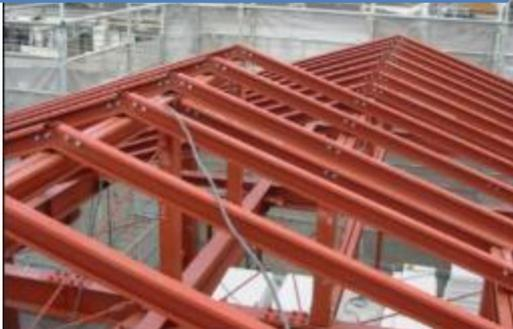
目的：壁や屋根を貼り付けるために柱や梁の間に取り付ける下地
